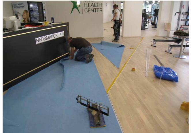
Типичная, часто встречающаяся ситуация для KE 2000 S: укладка ПВХ покрытия на подложку, (работа в офисе не прекращается), в данном случае – на UZIN RR 186.
